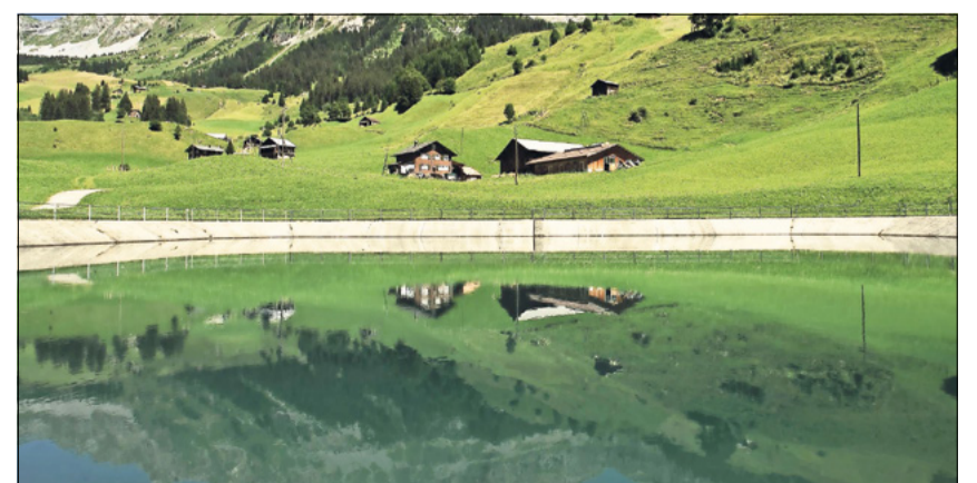
Das Ausgleichsbecken Leematt des KW Schächental. Das Kraftwerk produzierte im Geschäftsjahr 2016/17 rund 8 Millionen Kilowattstunden Strom. FOTO: ZVG
